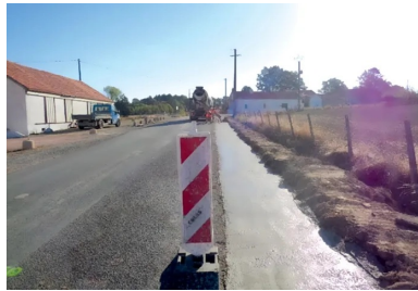
La chaussée ayant été sciée à 10 cm du bord, le Maces est mis en place sur des largeurs variant de 30 cm à 2 m.
