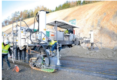
Assurant en une seule opération le coffrage et la vibration, la première machine à coffrages glissants (Wirtgen SP 1500) bétonne sur 17 cm d'épaisseur et sur 10 m de largeur. Au premier plan, le fil de guidage.
